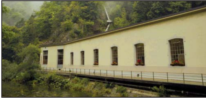
Usine des Moyats avec la conduite forcée.
