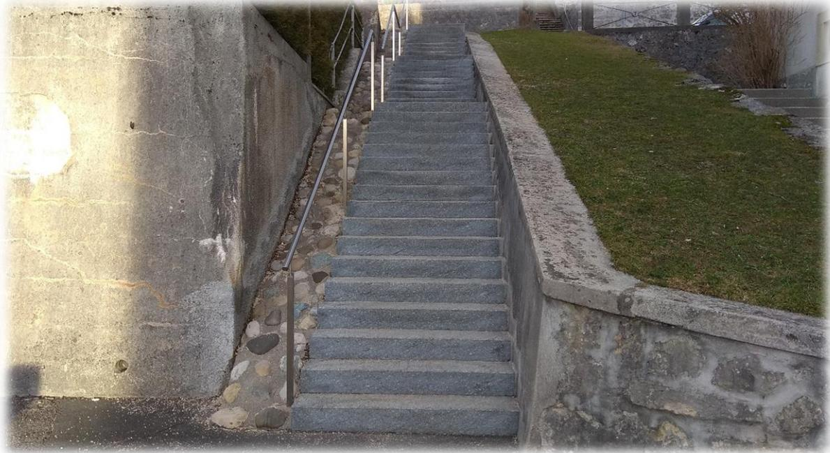
Le Conseil communal prévoit de ce fait la démolition de l'escalier existant, la réfection totale des fondations, la rénovation des murets et la mise en place d'une nouvelle main courante. Le palier sera exécuté à l'aide de pavés et des galets seront posés entre les murets et les nouvelles marches.
