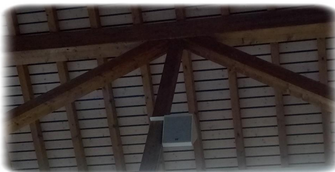
Haut-parleur situé au plafond des salles polyvalentes
