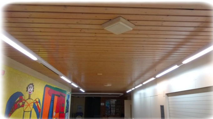
Haut-parleur situé au plafond du corridor
