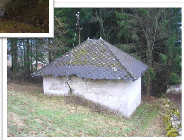
Cet ouvrage est très vétuste. En effet, nous sommes en sursis pour réfectionner l'installation électrique plus conforme qui n'a pas passé le contrôle de 2012. Une des deux pompes est à réviser et l'alimentation électrique de l'ouvrage serait à refaire (à charge du Groupe E). De plus, les chéneaux sont en très mauvais état.
