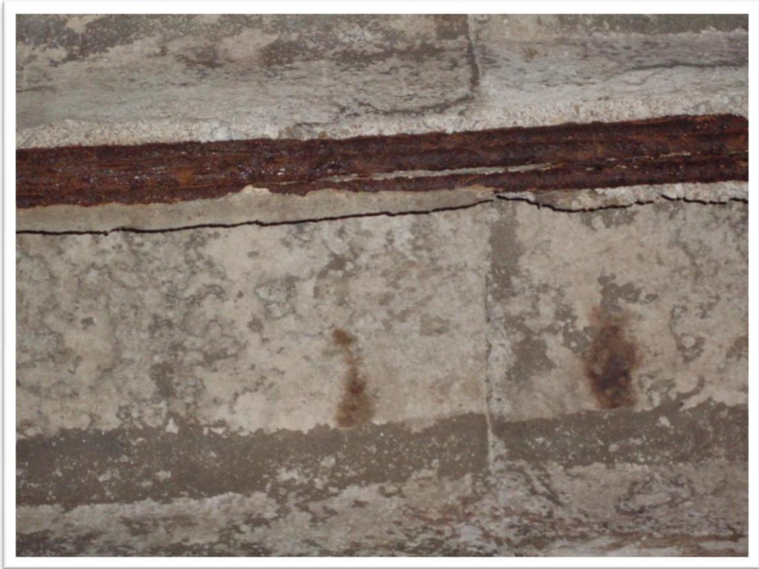
Le dégagement, dérouillage et protection anticorrosion et ragréage des aciers d'armatures apparents des sommiers.
