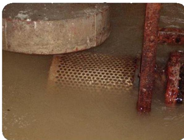
**La réfection de cet ouvrage est prioritaire**, l'expertise démontre un délabrement avancé de la partie maçonnerie qui va mettre sous peu l'ensemble de l'ouvrage en péril. Les autres mesures satisfont les exigences minimales pour garantir la qualité de l'eau sanitaire qui est considérée comme une denrée alimentaire.
