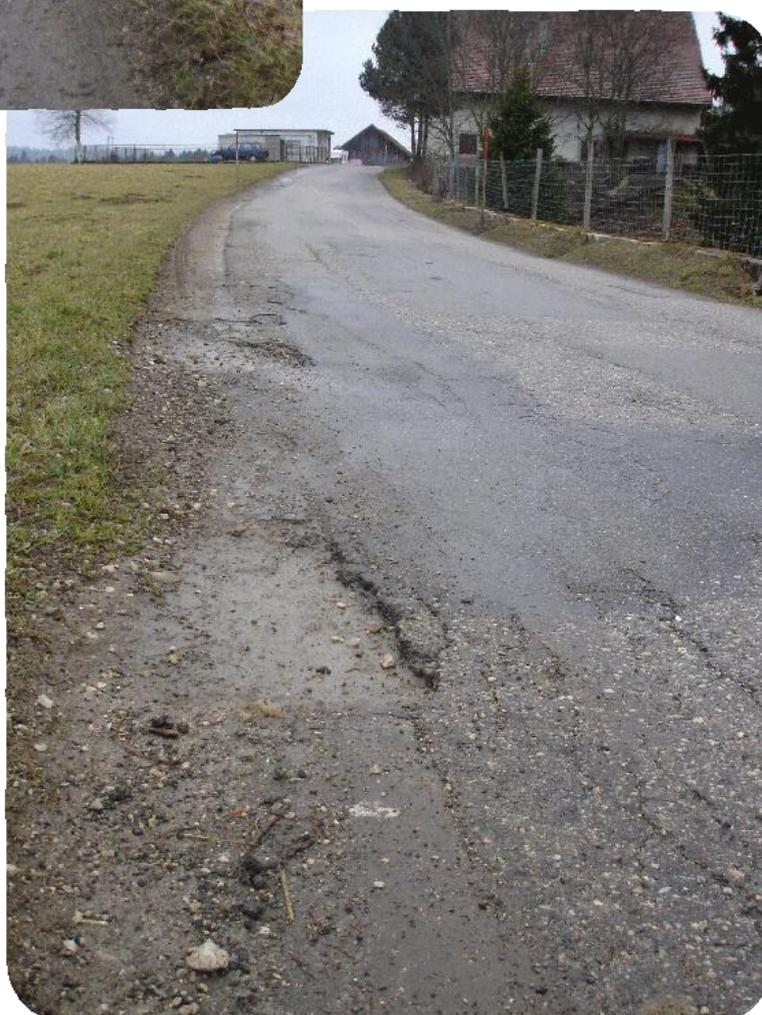
De ce fait, l'enrobé des ~650m de ce tronçon sera entièrement remplacé.
