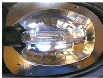
Luminaire avec optique performante Efficacité élevée : sodium HP
