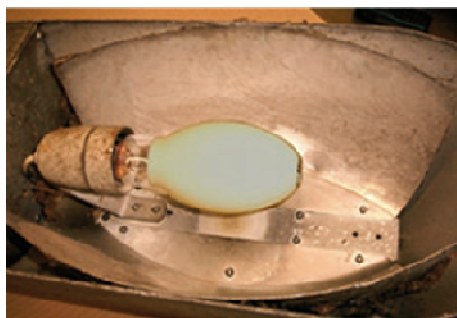
Ancien luminaire sans optique Efficacité lumineuse faible
