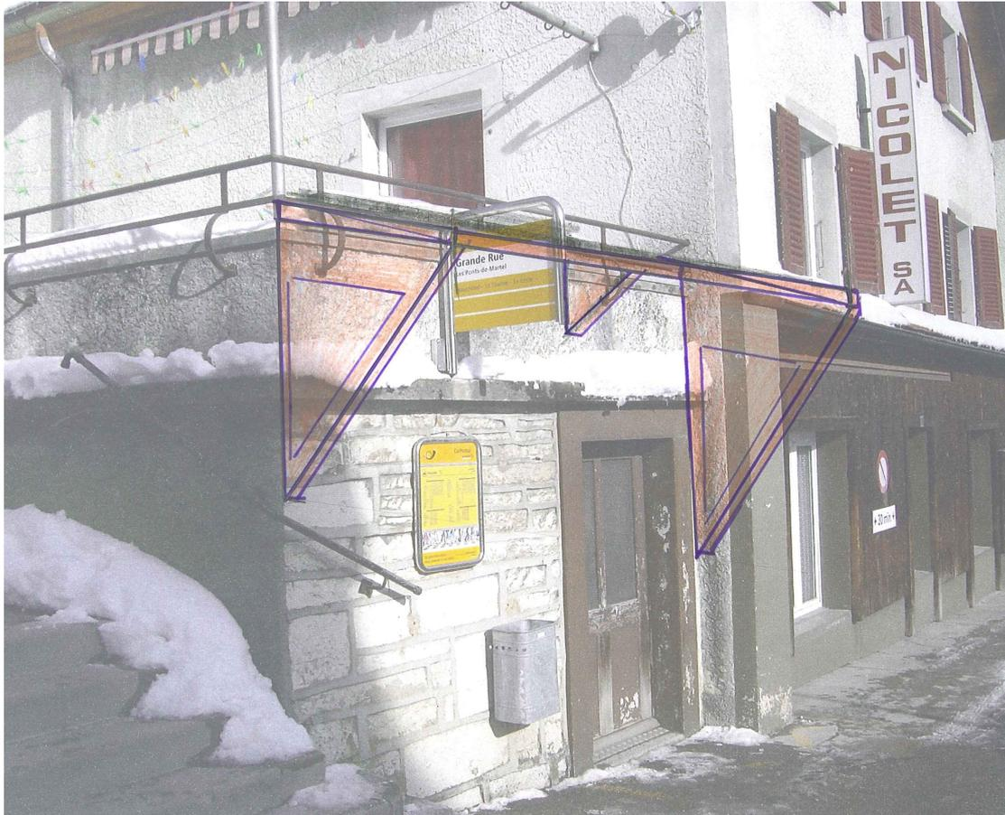
Sa longueur est de 3,2 mètres pour une largeur d'environ 1 mètre, posé à une hauteur de 2,6 mètres permettant le déneigement le plus proche possible de la maison.
