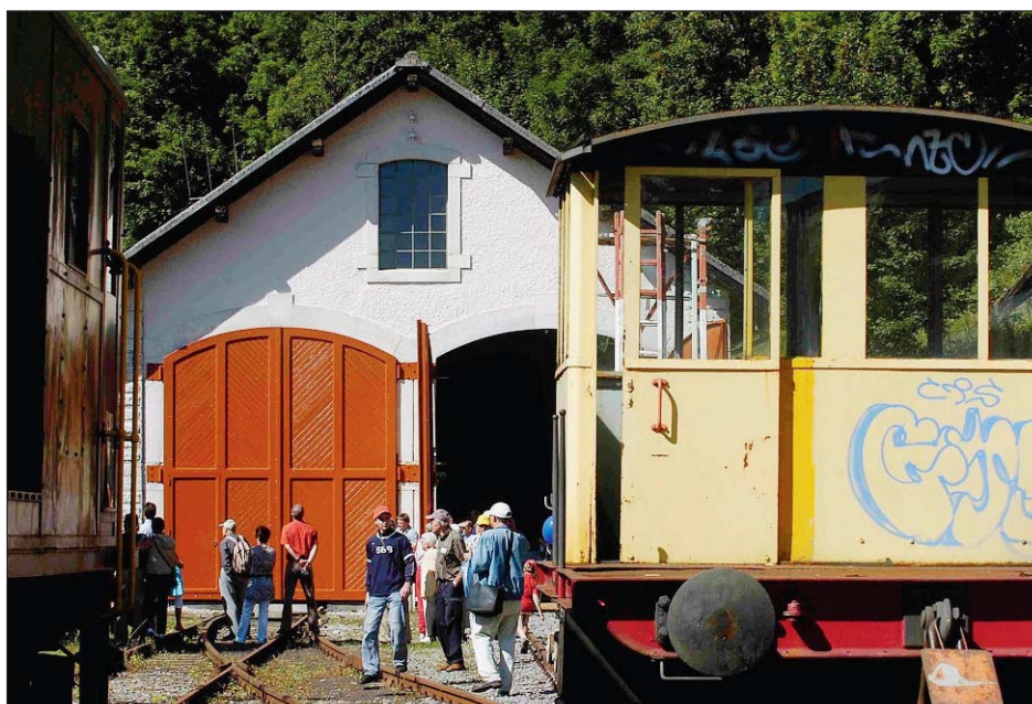
RENOUVEAU Partiellement restauré, le dépôt ferroviaire La Douanière, au Locle, a été inauguré samedi matin.
