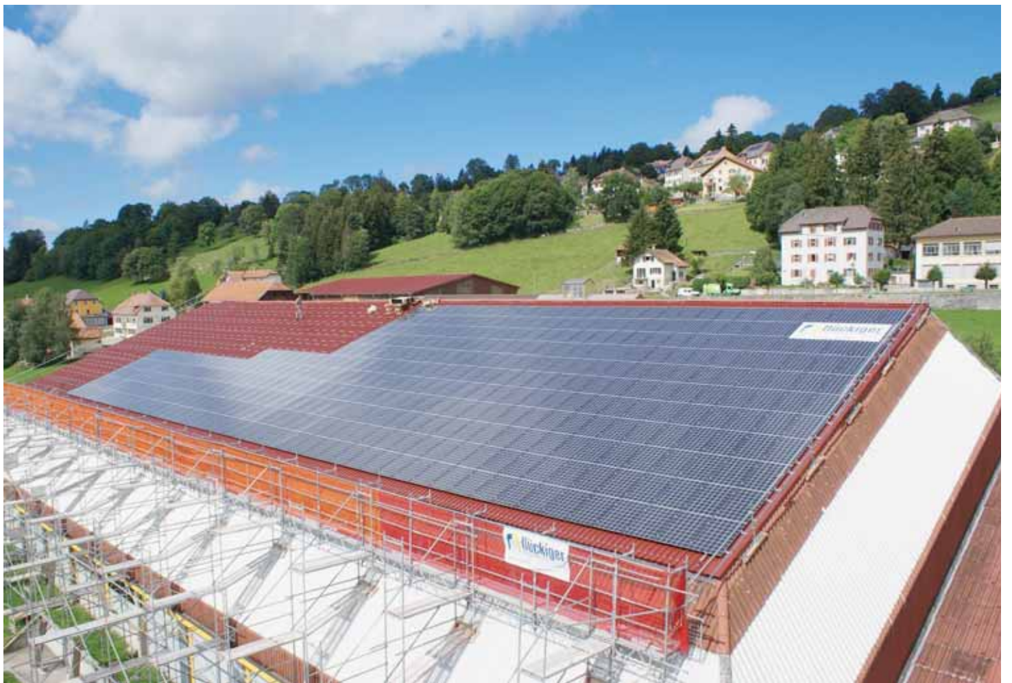
Cet été, pendant des travaux menés grand train: quasiment 1000 m 2 de panneaux photovoltaïques installés sur le toit de la patinoire du Bugnon, première réalisation de Sun Valley. SP
