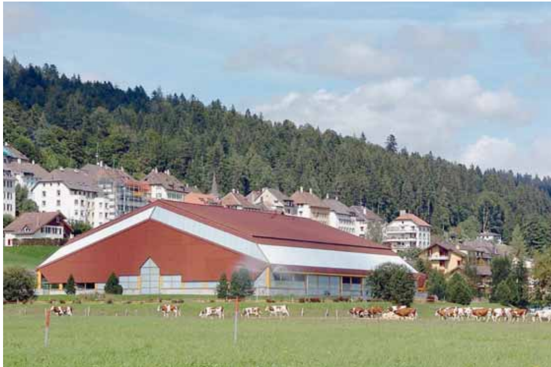
Du soleil sur le toit de la patinoire du Bugnon: plus de 1000 m 2 de panneaux photovoltaïques y seront installés dès début juillet. ARCHIVES RICHARD LEUENBERGER
