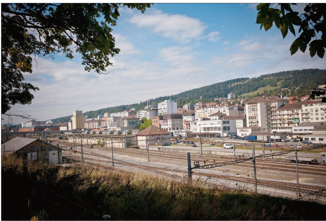
QUARTIER Au nord des voies, une première série de bâtiments (des locaux de stockage, propriété des CFF), sera démolie la semaine prochaine dans le cadre des travaux liés au futur quartier Le Corbusier. (ARCHIVES PERRET)
