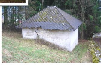
Cet ouvrage est très vétuste. En effet, nous sommes en sursis pour réfectionner l'installation électrique plus conforme qui n'a pas passé le contrôle de 2012. Une des deux pompes est à réviser et l'alimentation électrique de l'ouvrage serait à refaire (à charge du Groupe E). De plus, les chéneaux sont en très mauvais état.
